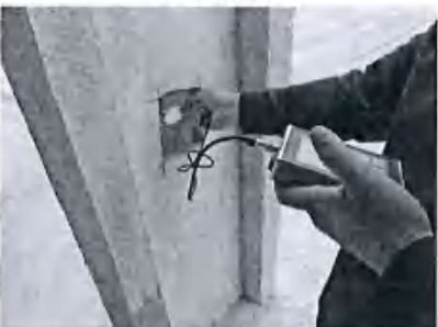
现场检测照片
