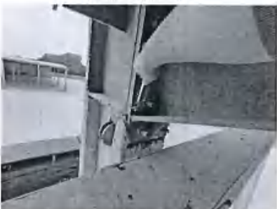
现场检测照片
