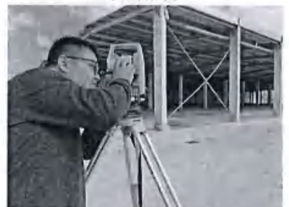
现场检测照片
