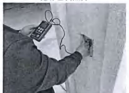
现场检测照片
