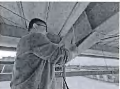
现场检测照片
