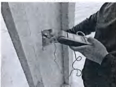
现场检测照片
