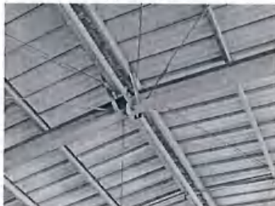
梁梁节点照片
